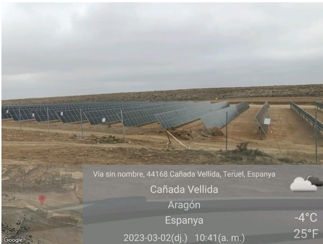
Ilustración 2. Vallado y placas de la zona 5
